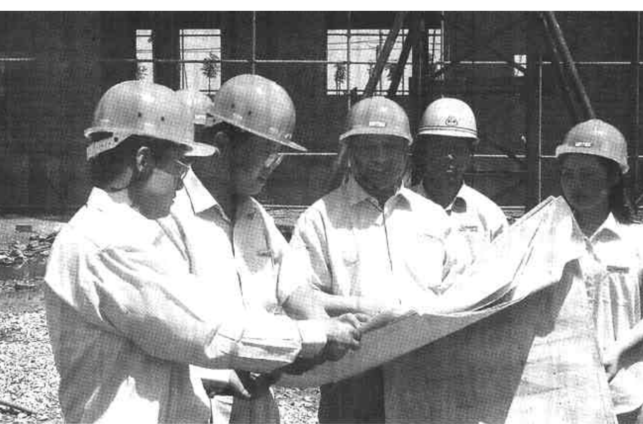
市直第十一批下派干部征尘未洗，第二批干部又带着市委的嘱托和群众的期待来到了基层，无论是在乡村的田间地头，还是在企业的施工现场，顶着酷暑的烈日，他们奔走在现场，用扎实的实际行动实践着自己的誓言。图为下派干部在迪发实业公司的黄河口木材市场工地上，熟悉工作流程和进展情况。(董保延 摄)
